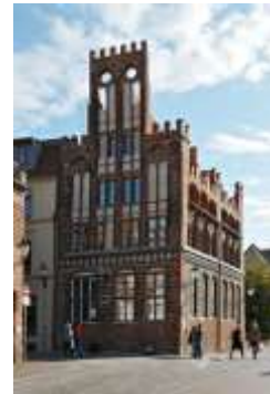
Archidiakonatsgebäude Wismar © Volster & Presse HWI
